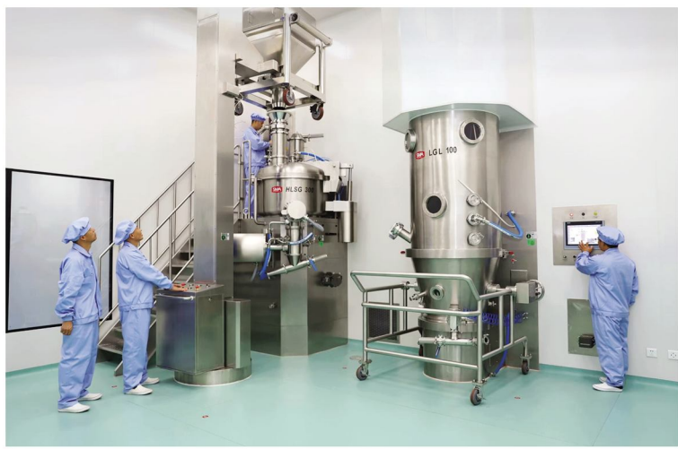
吉林四环口服固体制剂产业化车间进行湿法制粒及流化床干燥设备调试工作
